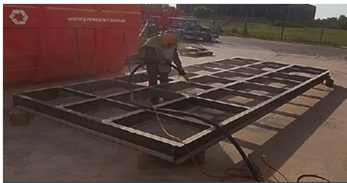
Figura 4. Tratamiento del bastidor de piso
