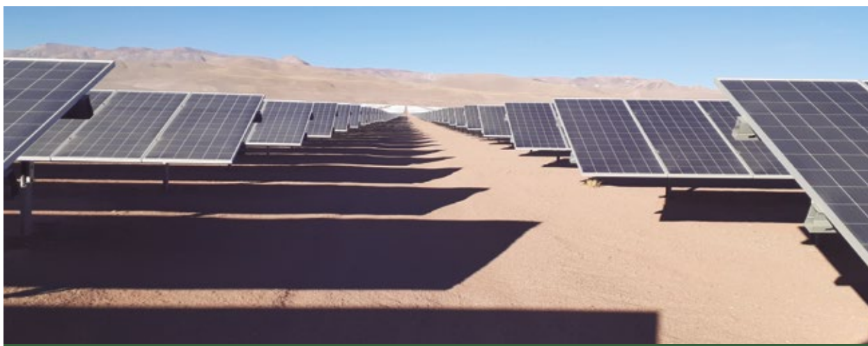
Paneles solares desde subplanta Fuente: Manuel Arequipa
